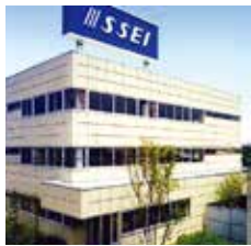
■本社/事務・技術棟
